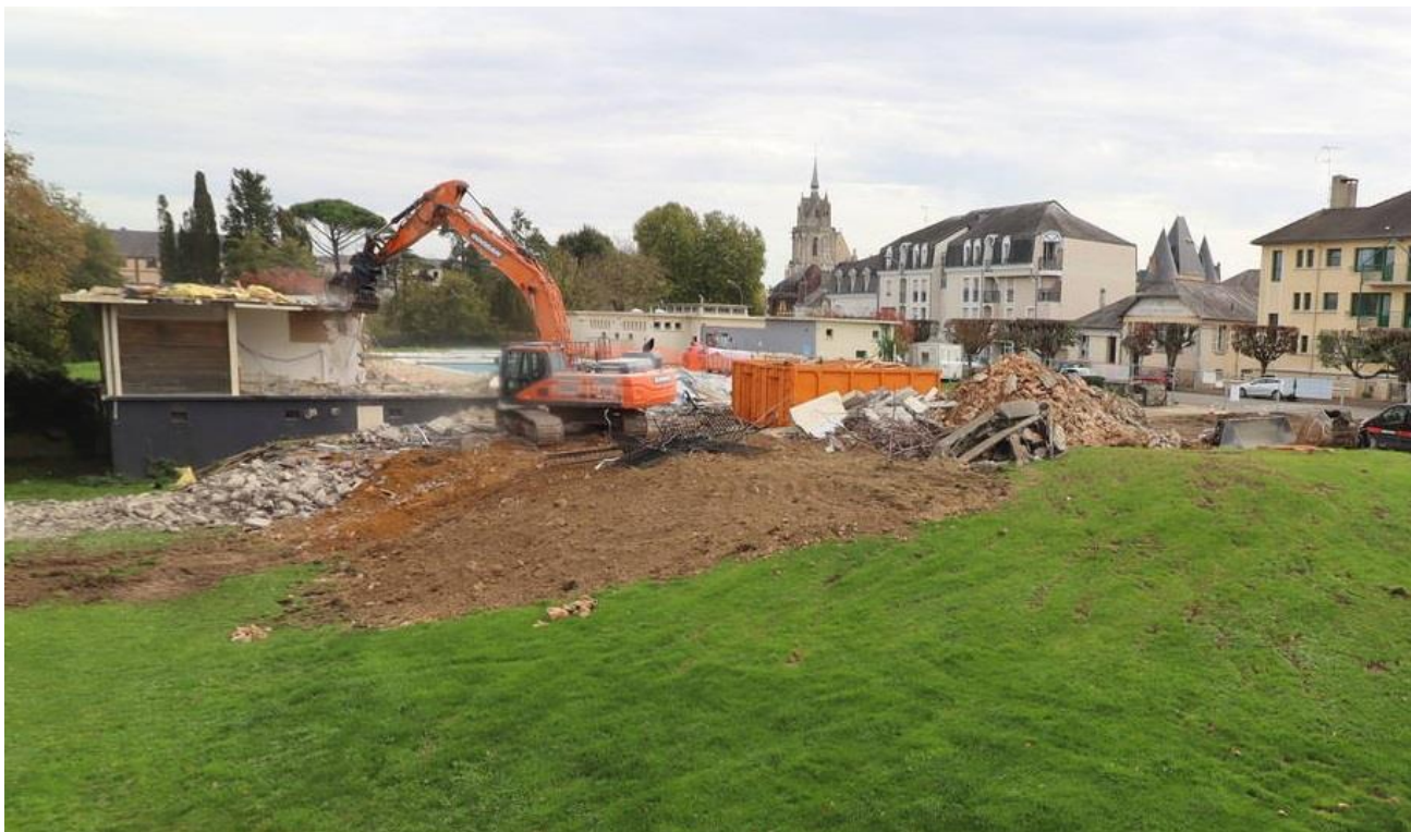
Lancement des travaux du centre aquatique en octobre 2022
